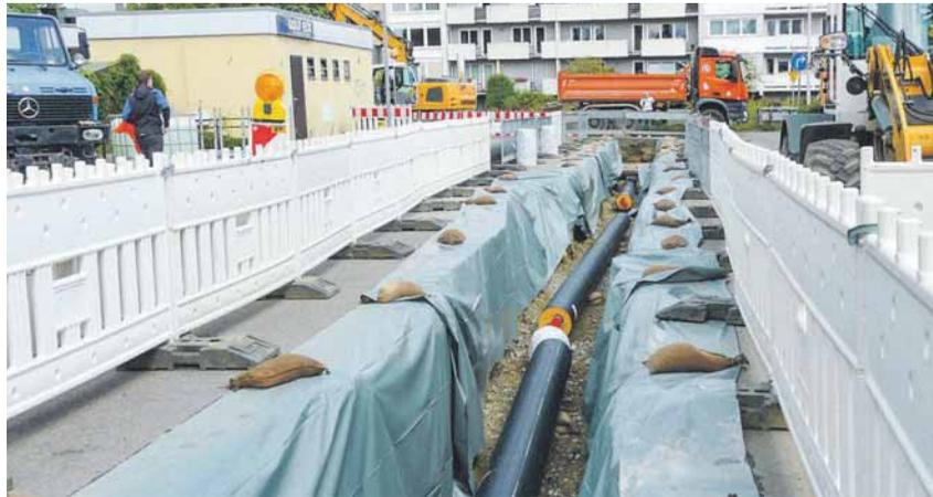
Von der Heizzentrale Memelstraße werden für das Nahwärmenetz Leitungen zu den Gymnasien verlegt. Foto: BIKO
