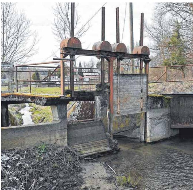
Das alte Wehr im Bereich der Unteren Mühle wird durch eine Raue Rampe ersetzt, das macht die Weihung in diesem Bereich durchgängig für Fische.
